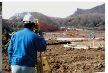
大型土木工程現場
